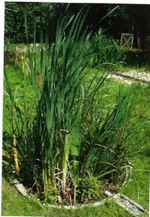
Bassin de filtres plantés en plein été.
