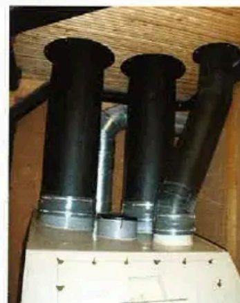
Les tuyaux des toilettes et du broyeur à végétaux aboutissent dans la cuve de compostage.
