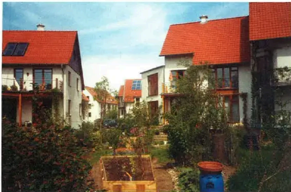
À Bielefeld, ce lotissement est équipé de toilettes à compost.
