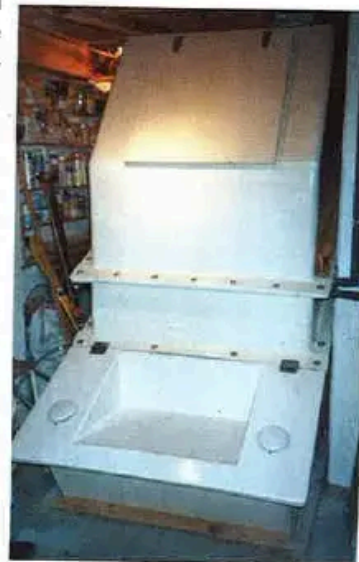
Chambre de compostage située en partie basse de l'habitation.
